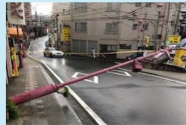
暴風により街路灯が倒れる様子
