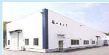
倒壊した工場・施設等の復旧支援
