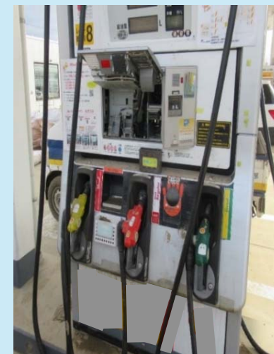
（左）冠水被害を受けたSS／（右）水に浸かり使用不能となった計量機（長野県長野市）
